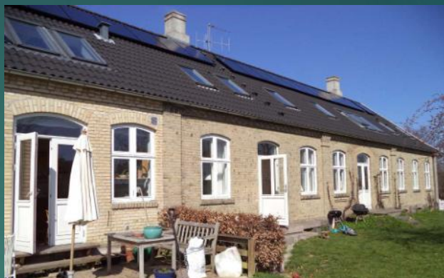
Panele słoneczne na dachu
