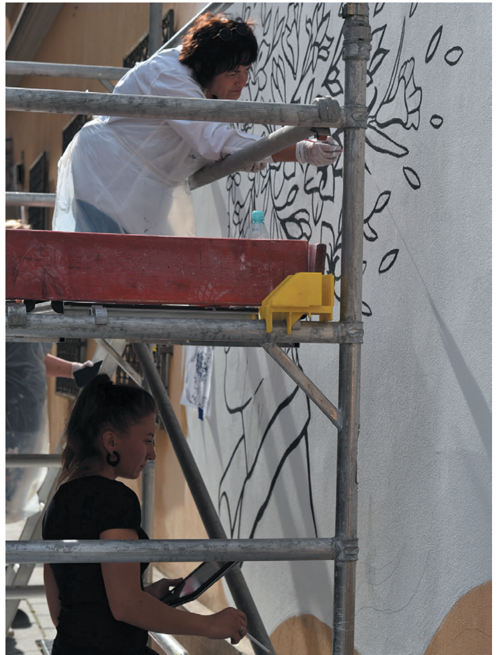
foto. Prace nad murem, który pojawi się w stolicy Wielkopolski.
