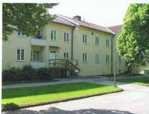
Wejścia A, B i C. Fot. Evert Hassblom.
