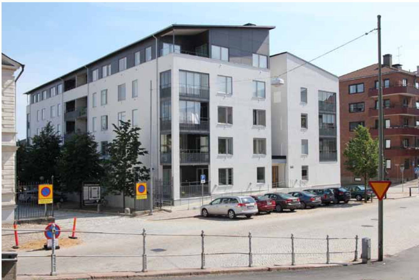
Bataljonen od strony głównego wejścia, w kierunku ulicy Drottninggatan. Wspólne pomieszczenia znajdują się w najbliższym rogu od ulicy i wejścia na kondygnację parteru. Fot. Kerstin Kärnekull.
